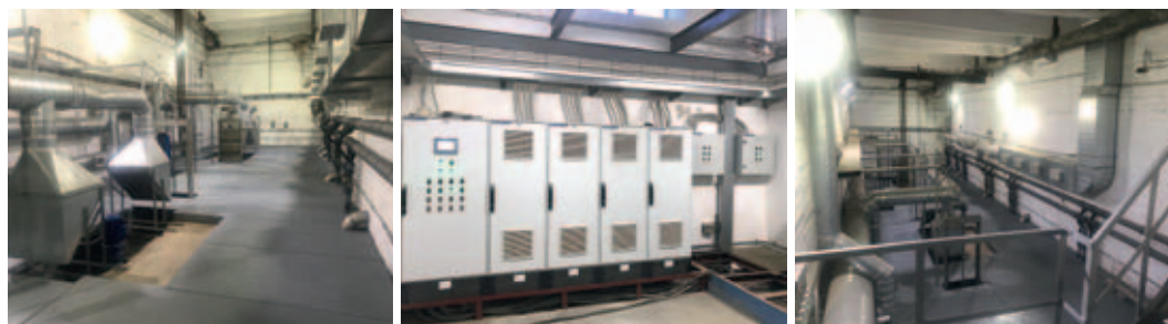
Рис. 5. Состояние КНС № 11 (г. Кириши) в процессе реконструкции и по ее завершении. 2018 год
