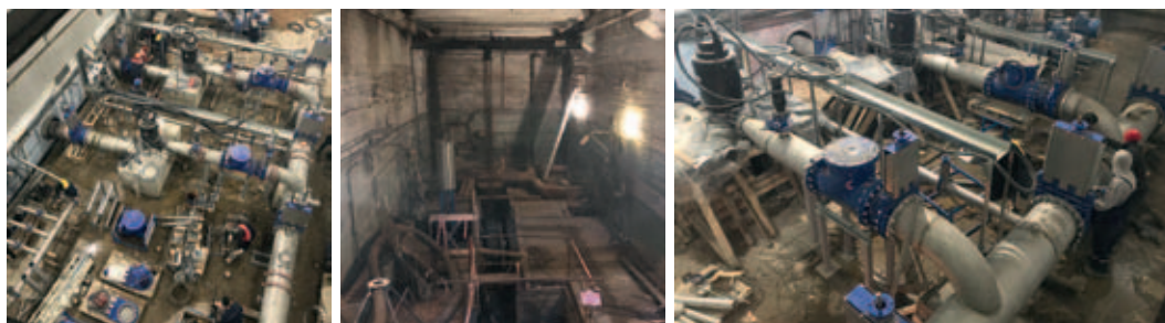
Рис. 3. Фактическая реализация размещения МАНС СтокПРО для обеспечения временной схемы подачи стоков при реконструкции КНС № 11 (г. Кириши), 2018 год
